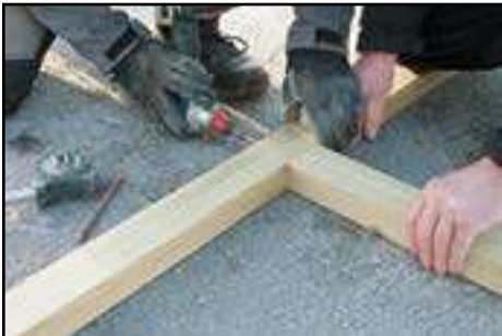
Fundamenthölzer verschrauben
