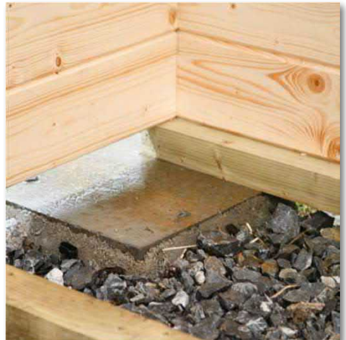
Verdichtetes Schotterbett mit Gehwegplatten als Minimaluntergrund für die Errichtung eines Hauses.
