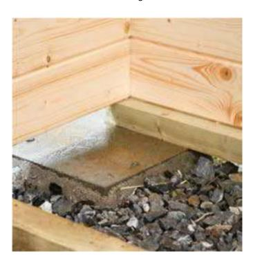
**Verdichtetes Schotterbett mit Gehwegplatten** als Minimaluntergrund für die Errichtung eines Hauses.
