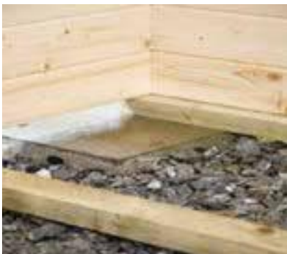
Schotterbett mit Gehwegplatten als Minimaluntergrund für die Errichtung eines Gartenhauses
