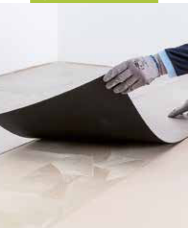
Verklebung von LVT Fliesen mit planeo Klebstoff SafeBond
