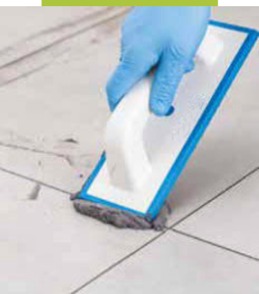
Verfugen mit planeo FlexProtect
