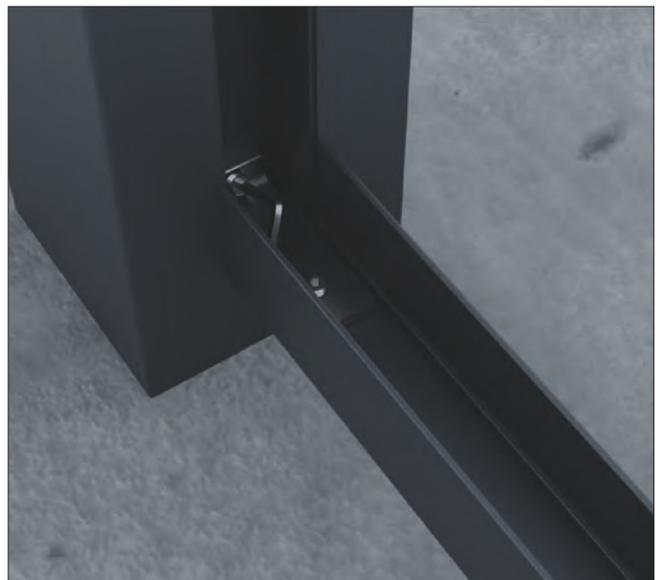
Es ist möglich, vor dem Einbau der Zaunprofile die Pfosten provisorisch aufzustellen. Um das lichte Maß von 1750 mm sicherzustellen eignet sich die untere Schiene (siehe 1.5.)
