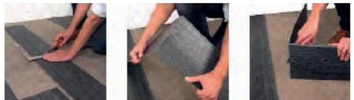
Die Elemente müssen spannungsarm und fugendicht in den Kleber eingelegt und angerieben werden. Innerhalb der offenen vorgeschriebenen Zeit des Klebers, muss sorgfältig mit einer Lamellenwalze angedrückt werden. Bis zur vollen Durchhärtung des Klebers ist der Boden vor Temperaturänderungen und Sonneneinstrahlung zu schützen.
