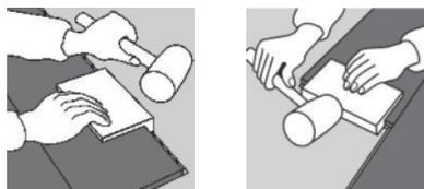
Die Elemente der letzten Reihe werden zugeschnitten und passgenau mit 10 mm Abstand zur Wand eingesetzt.
