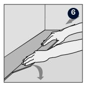
Drücken Sie die Längsseite der ersten Diele der zweiten Reihe im Winkel gegen die davor liegende Diele. Pressen Sie die Diele weiter nach vorne und legen Sie sie gleichzeitig an den Boden an.
