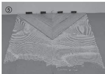
Déposer la colle le long du cordeau à l'aide de la spatule spéciale D. La largeur de la bande de colle doit correspondre à une largeur d'élément de part et d'autre du cordeau. Poser les éléments préalablement disposés et assemblés dans le lit de la colle. Ne pas encoller une trop grande surface : les lames doivent être posées dans les 15 minutes suivant l'application de la colle.
